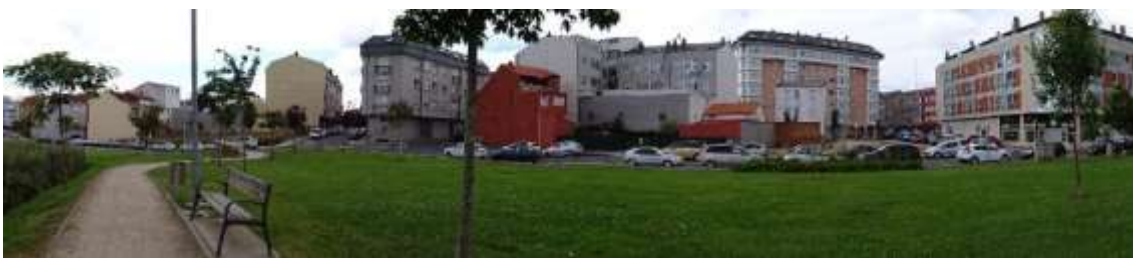
Exemplo de paredes medianeiras vistas na trama urbana de Narón
