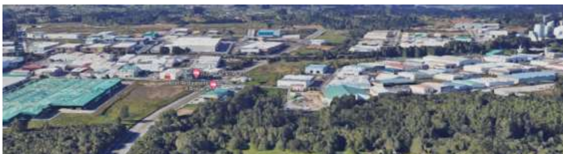
Vista do Polígono en 3D dende o sur (Fonte Google maps)
