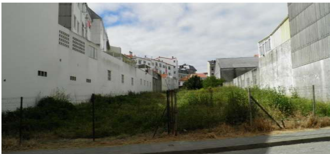
Vista de solar e medianeiras a vista na rúa Eirexa
