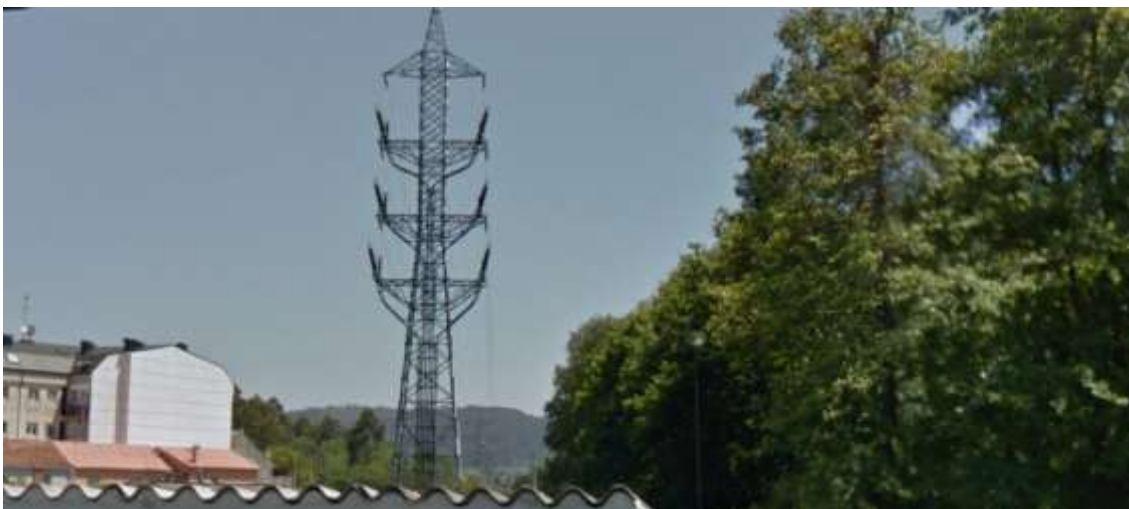
Vista da liña de alta tensión dende a rúa Zorrilla
