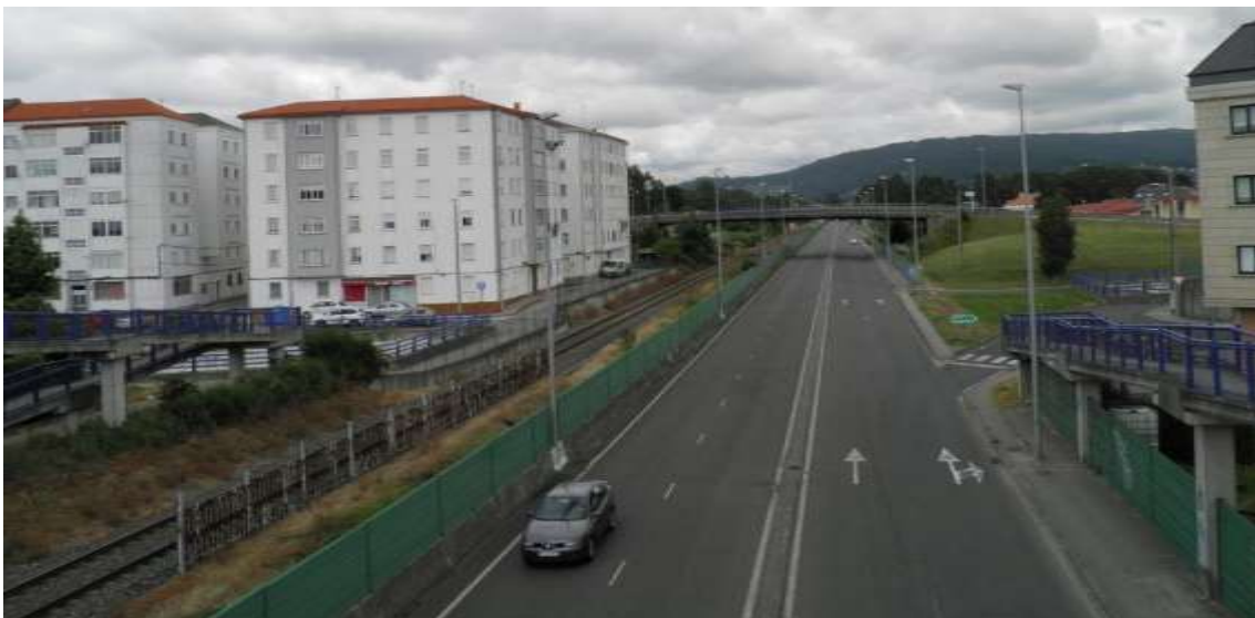
Vista do vía do Ferrocarril e a estrada de alta capacidade que divide o casco urbano
