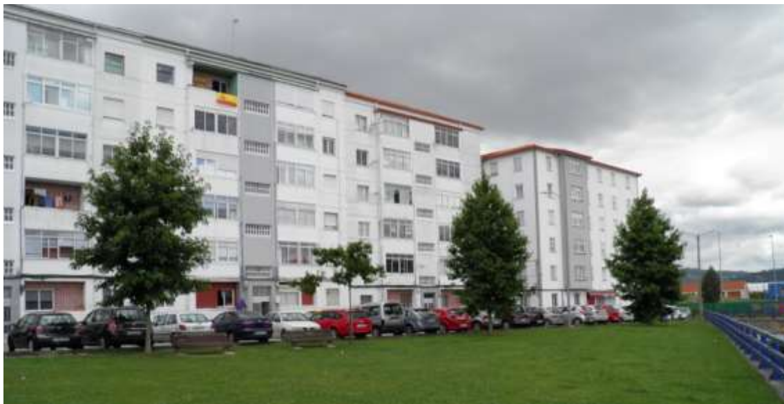
Vista das edificacións en altura do entorno da rúa Río Masma, concretamente dende a rúa Obispo Argaya Coicoechea
