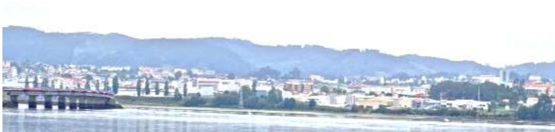
Vista de polígono da Gándara dende o outro lado da ría
