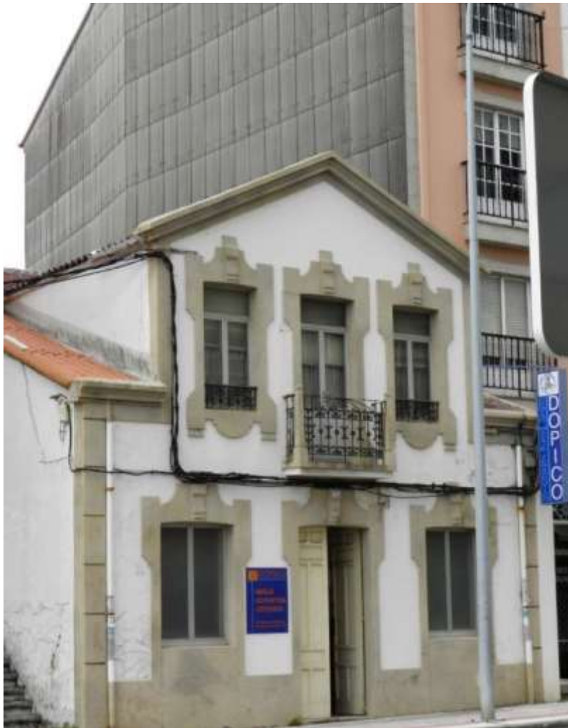
Edificación recente asolagando unha vivenda tradicional
