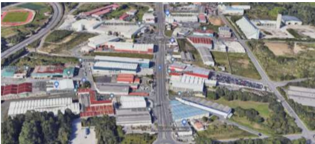
Vista do Polígono en 3D dende o sur (Fonte Google maps)
